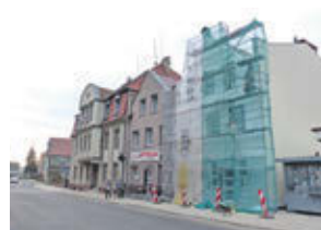
Nowy właściciel kamienicy dokończył jej gruntowny remont
