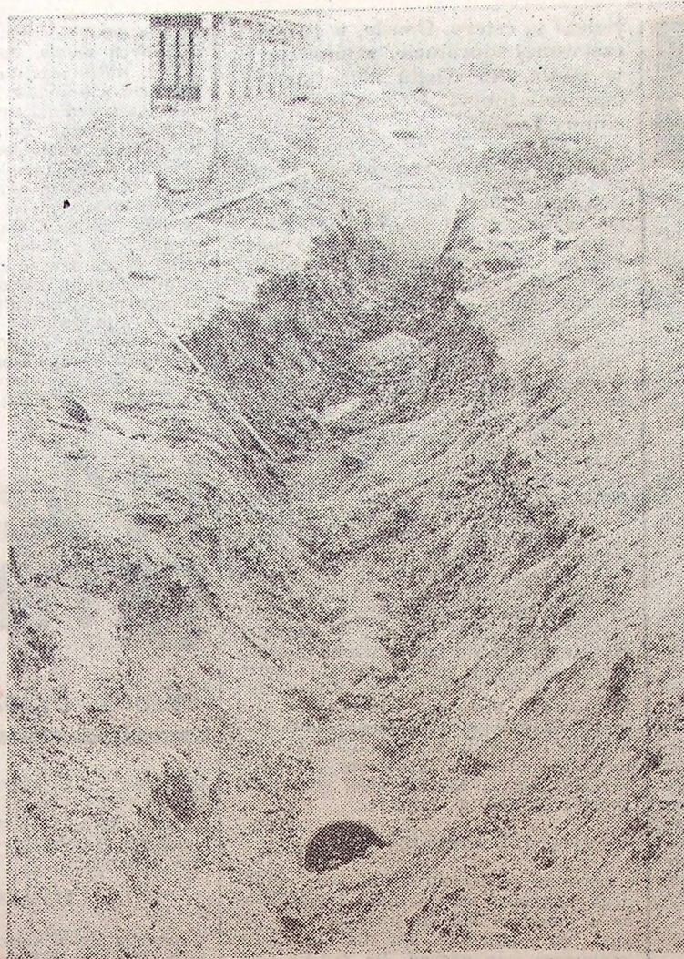
Widok rozkopanej instalacji zewnętrznej. Końca robót nie widać.
