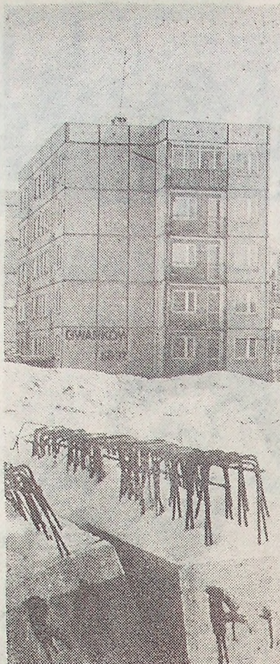
Obciążenie lokatora, to wyjście najprostsze z możliwych.
