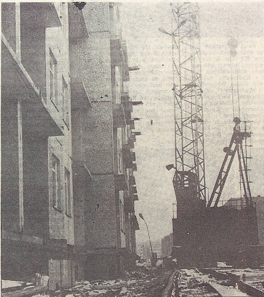
Bloków, które pochłaniają gigantyczne ilości materiałów budowlanych i są niebotycznie drogie — i na etapie budowy, i na etapie eksploatacji — jest wiele.
