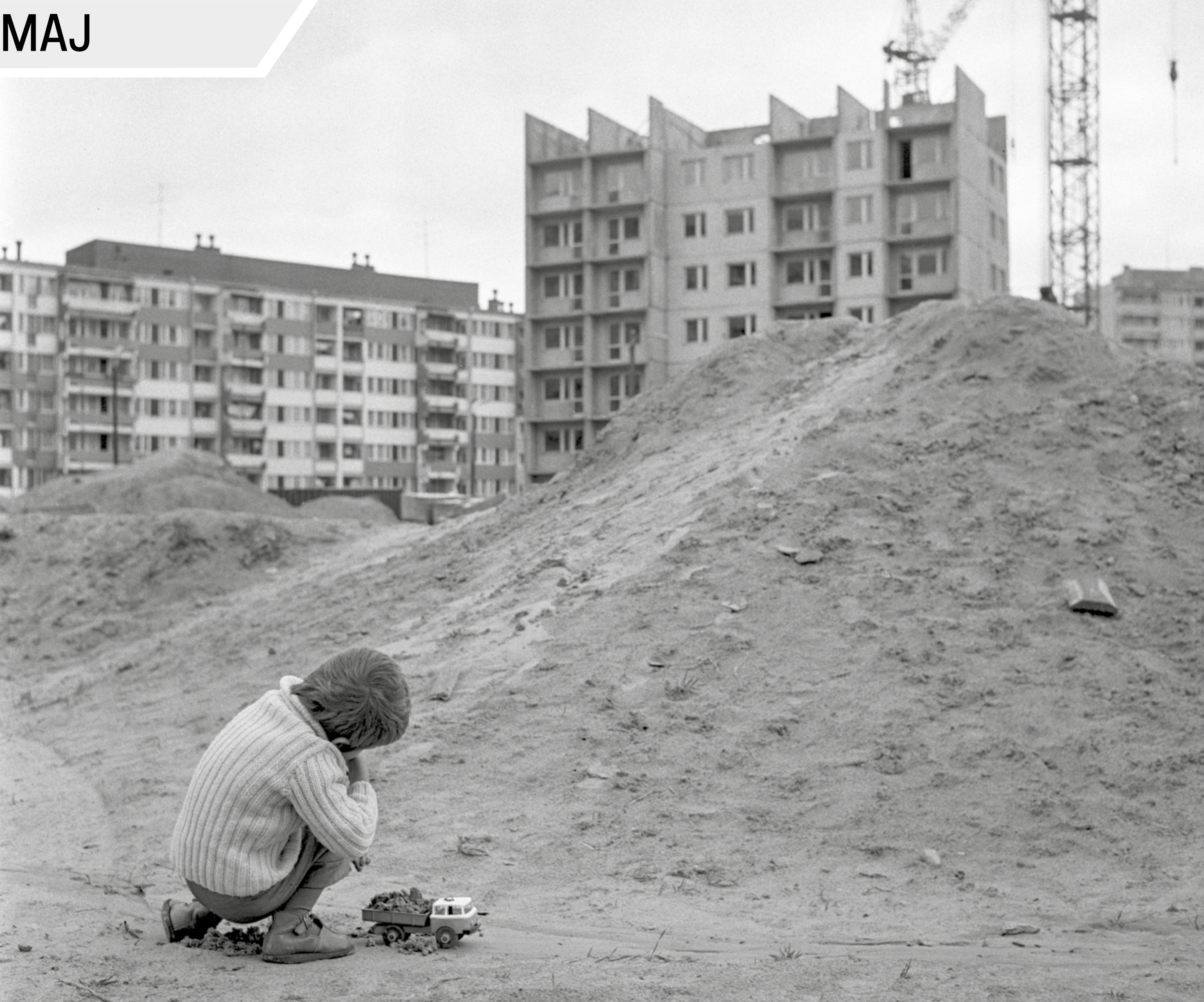
Budowa osiedla w Lubinie.
