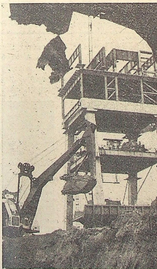
Rosną konstrukcje zakładu wzbogacania rud miedzi w kopalni „Rudna”.
