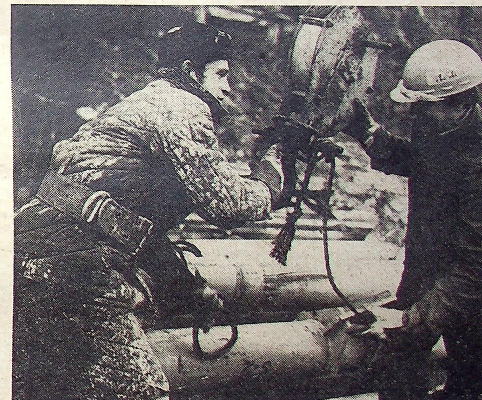
Józef Nowicki i Roman Tworowski podwieszają do dźwigu kolejny element anteny. To już historyczne zdjęcie.
