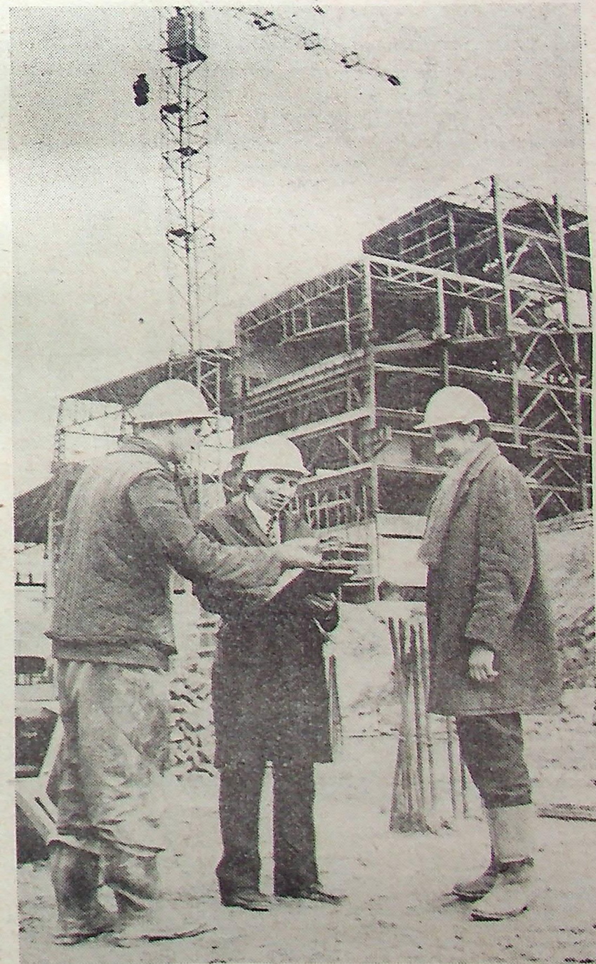
Krótką naradę na stanowisku pracy. Główny inżynier budownictwa powierzchniowego, Włodzimierz Butrymowicz (w środku) z Zygmuntem Polciem i Józefem Piszczkiem.
