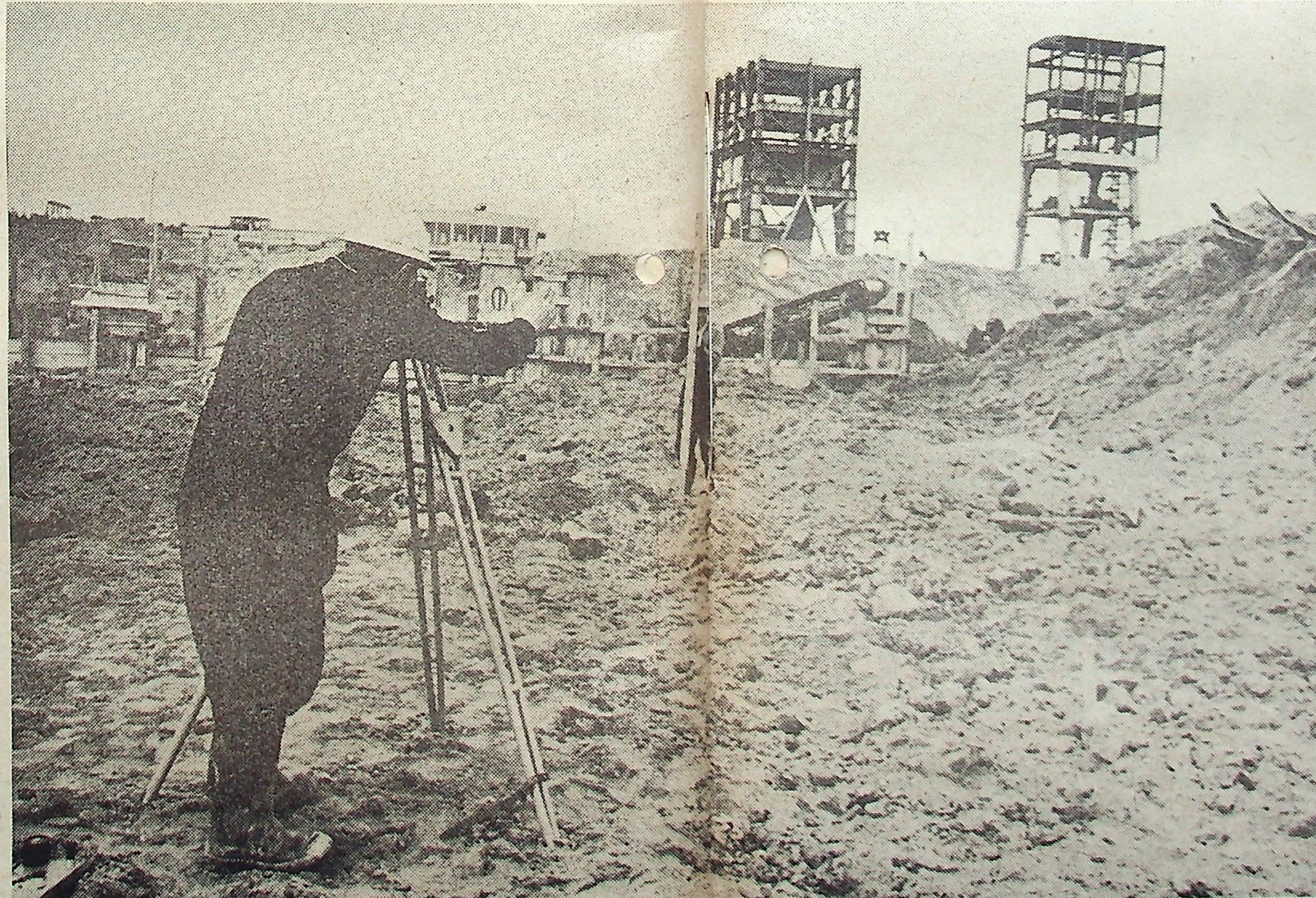
W tym miejscu powstanie „budynek socjalny”. Przy niwelatorze Zdzisław Sulek, w głębi Wiesław Socha.
