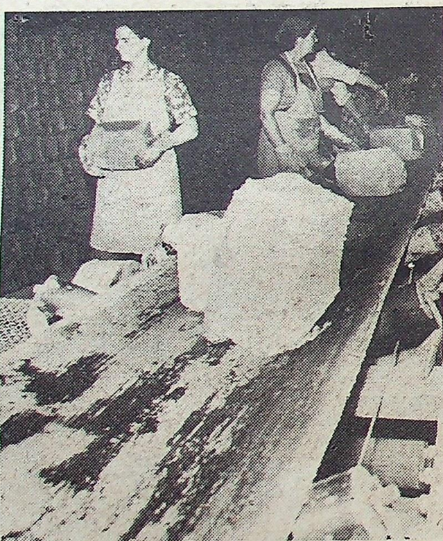
Każda z tych „kostek” waży 13 kilogramów. Każda z tych kobiet przerzuca w ciągu jednej zmiany 20 ton masy kamionkowej. Ponad tysiąc pięćset kostek.
