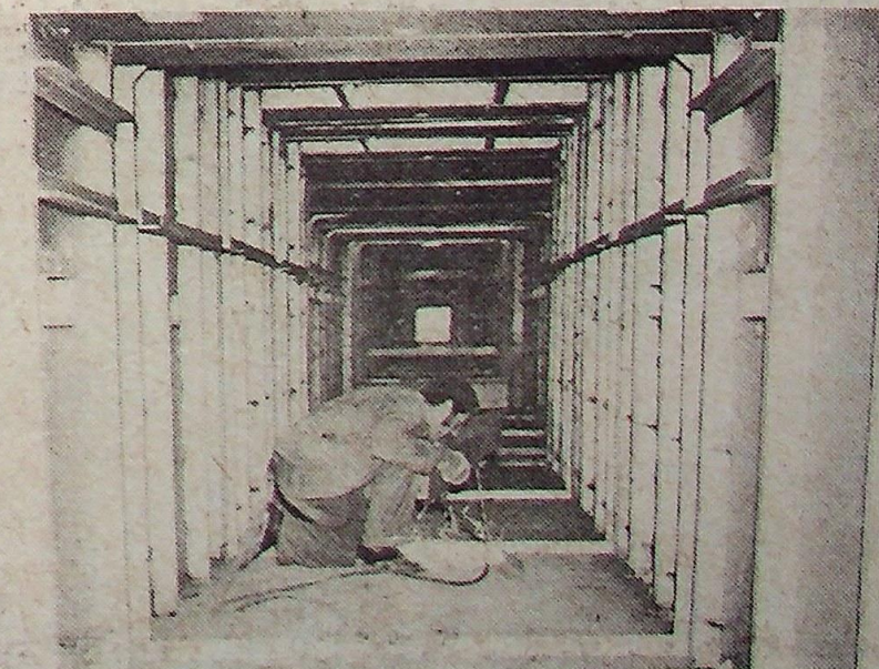
Pracownicy z wrocławskiej „Piecobudowy” przygotowują pierwszy doświadczalny piec tunelowy. To będzie być może początek wielkich zmian w zakładzie.
