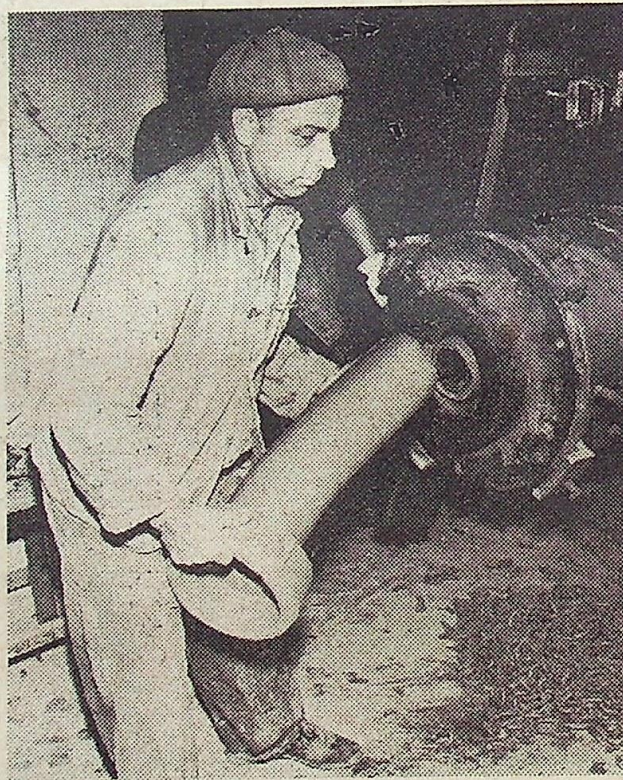
Maszyna wyciska rurę. Trzeba ją umiejętnie, odbierając z maszyny uformować. Bez formy, „na oko”, ale precyzyjnie.
