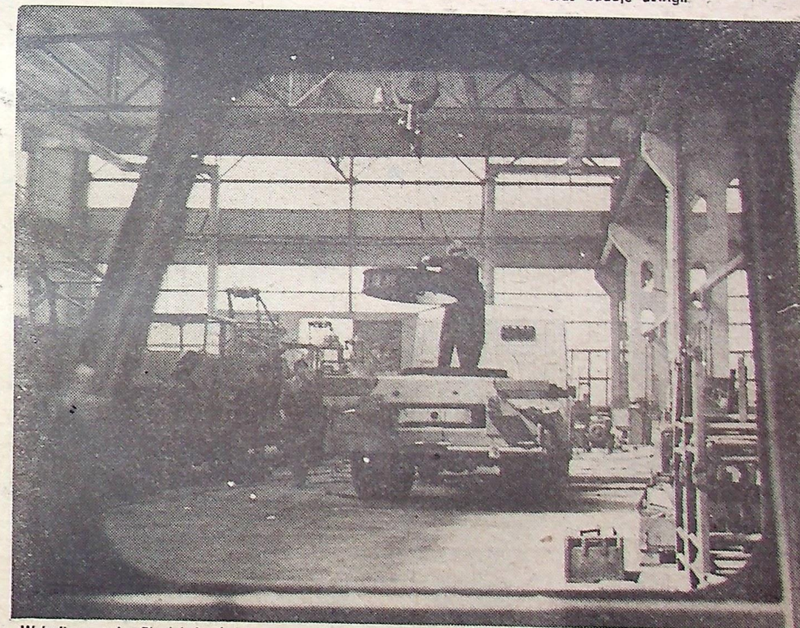
W hali montażu. Pierścień dźwigu montują Jerzy Iwański i Piotr Malicki.
