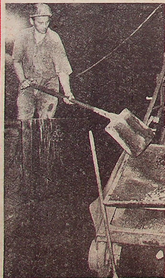
Jerzy Wydrych z Zakładu Budowy Kopalń w czasie wyładunku z wozu kopalnianego na taśmę zaprawę torkretową.
