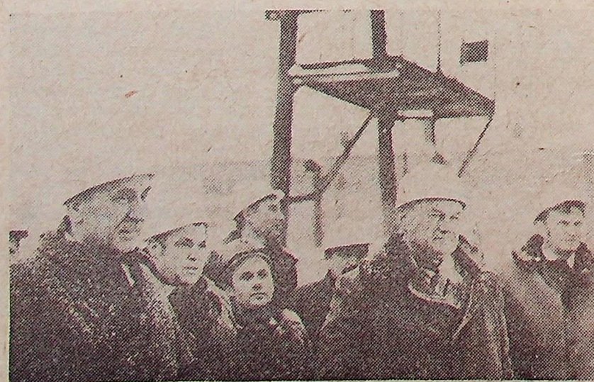
Na terenie ZG „Rudna” w budowie.
