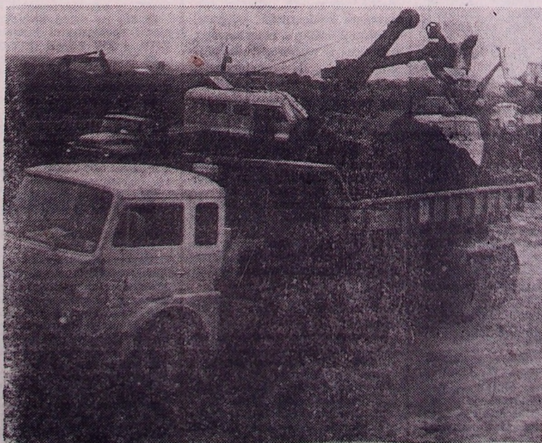
Nowy czterobrygadowy system pracy operatorów przy załadunku piasku posadzkowego dla potrzeb kopalni zwiększył zdolność produkcyjną.
