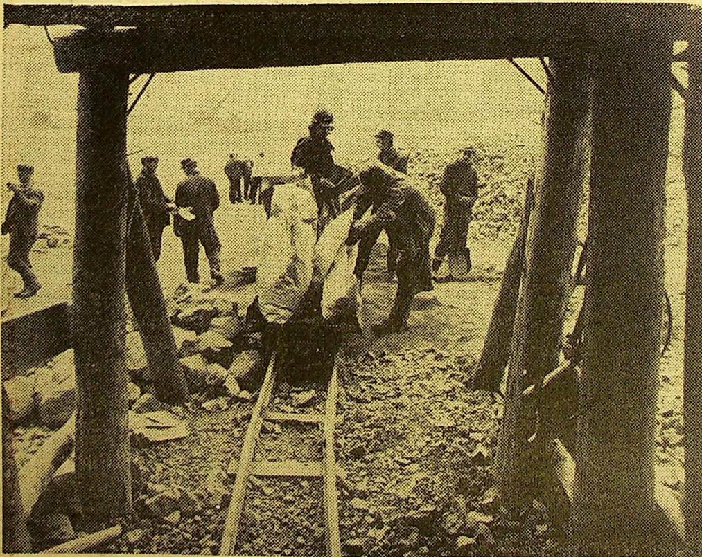
Sztolnię trzeba dokładnie i szczelnie zamknąć. Służy do tego miał kamienny w papierowych workach.
