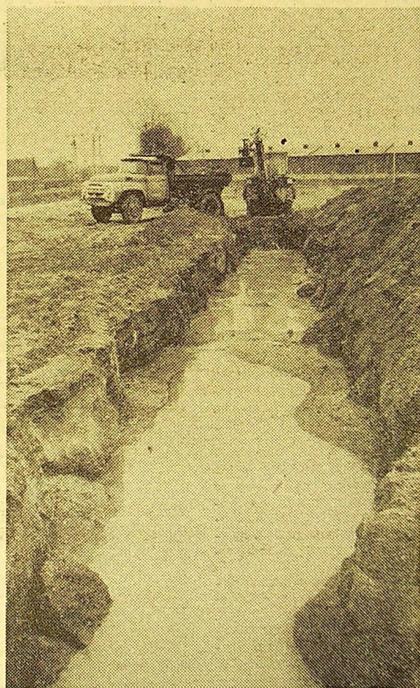
Pierwsze wykopy pod fundamenty chłodni.
