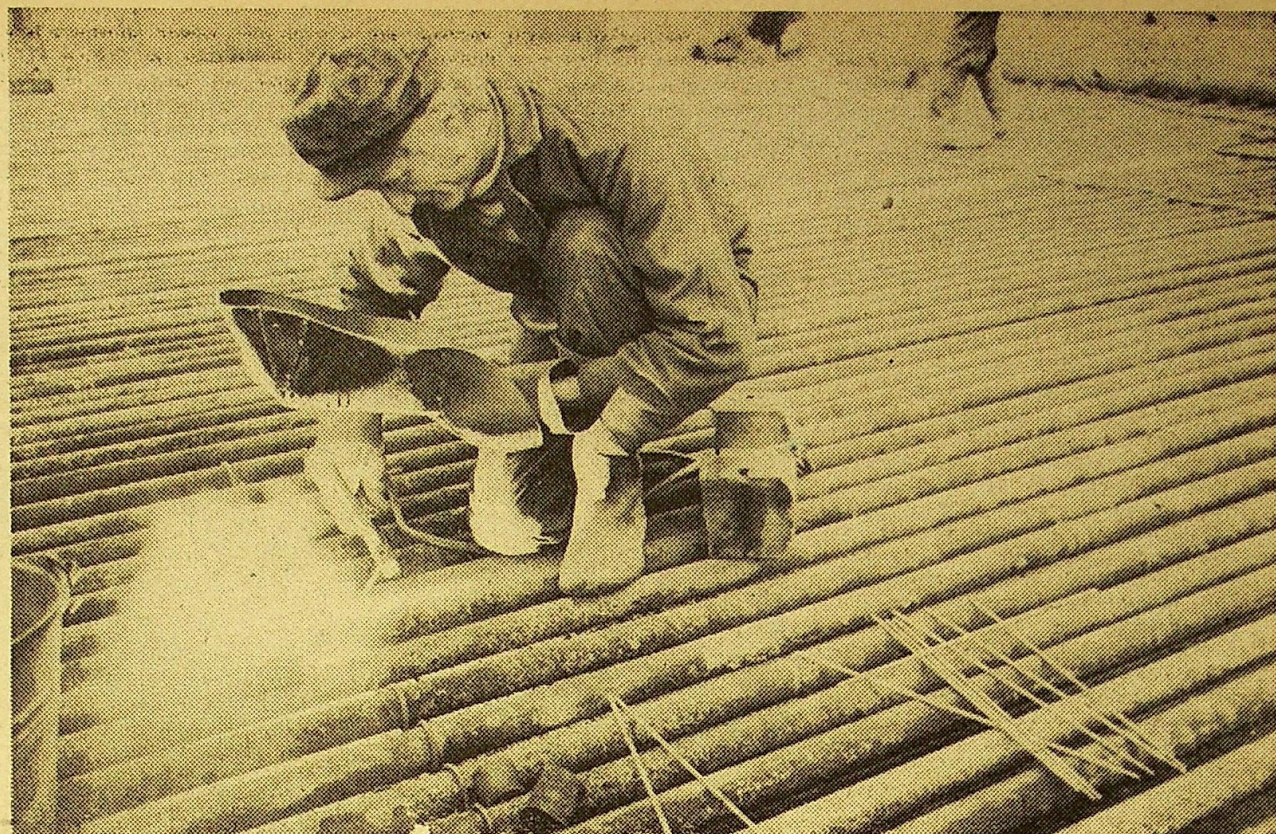
Płyta lodowiska już prawie zmontowana. Jeszcze trzeba ją zalać betonem.
