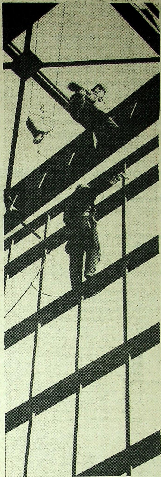
Trwa montaż konstrukcji nadszybia R-1.
