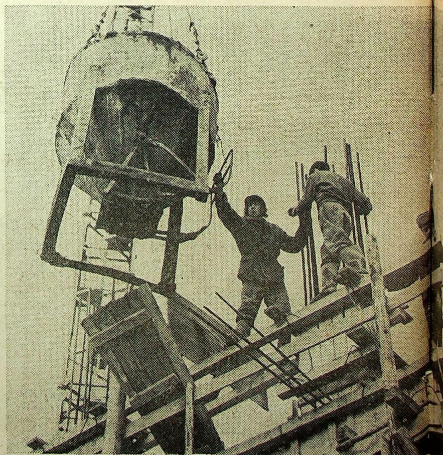
Na każdym kroku rosną betonowe konstrukcje. Na zdjęciu betoniarze... ski i Zygmunt Bialek.
