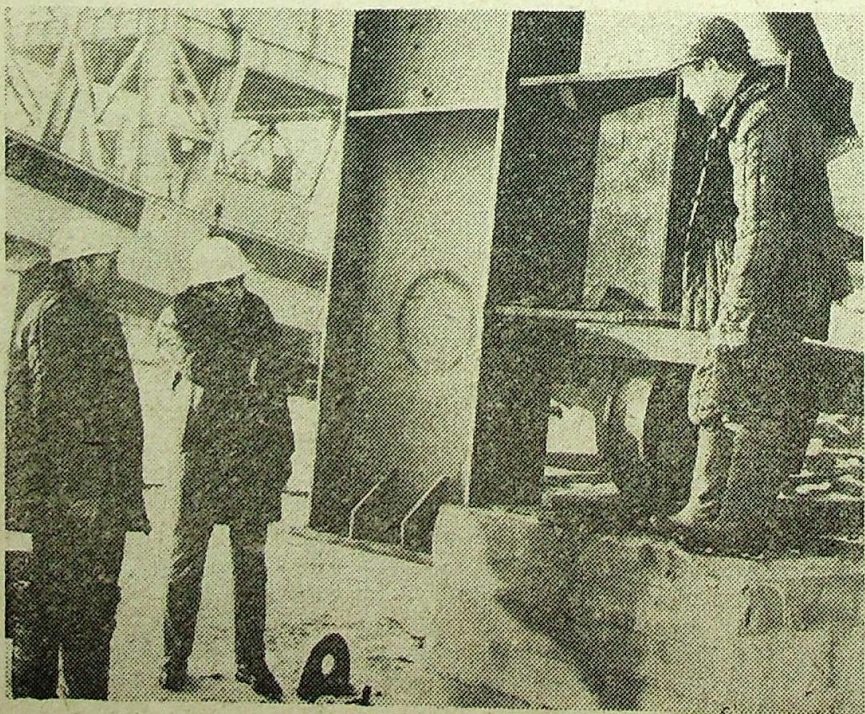
„Tak przygotowaną konstrukcję nadszymbia R-1 – pokazuje główny inżynier budowy Włodzimierz Butrymowicz – trzeba będzie przesunąć o około 55 metrów. Dzięki temu termin oddania szybu do eksploatacji skrócimy o sześć miesięcy”.
