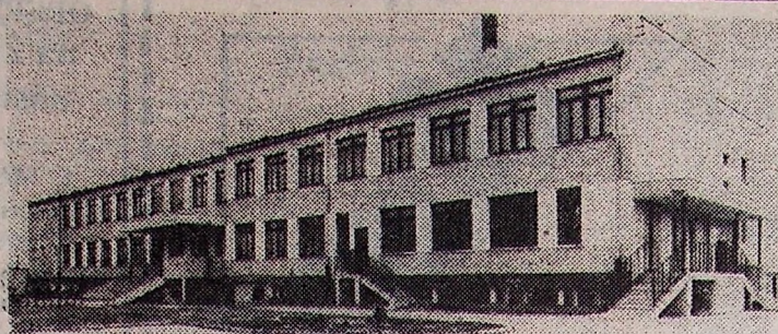
Na dokończenie budowy Szkoły Podstawowej w Budziszowie Wielkim Rada Gminy wyasygnowała 200 mln zł. Wszystkie obiekty oświatowe samorząd chciał przejąć od kuratorium, ale spóźnił się z podjęciem uchwały.
