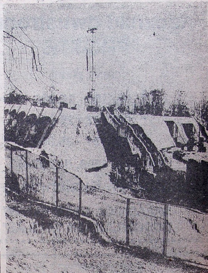
Tak budowa wygląda dzisiaj.
