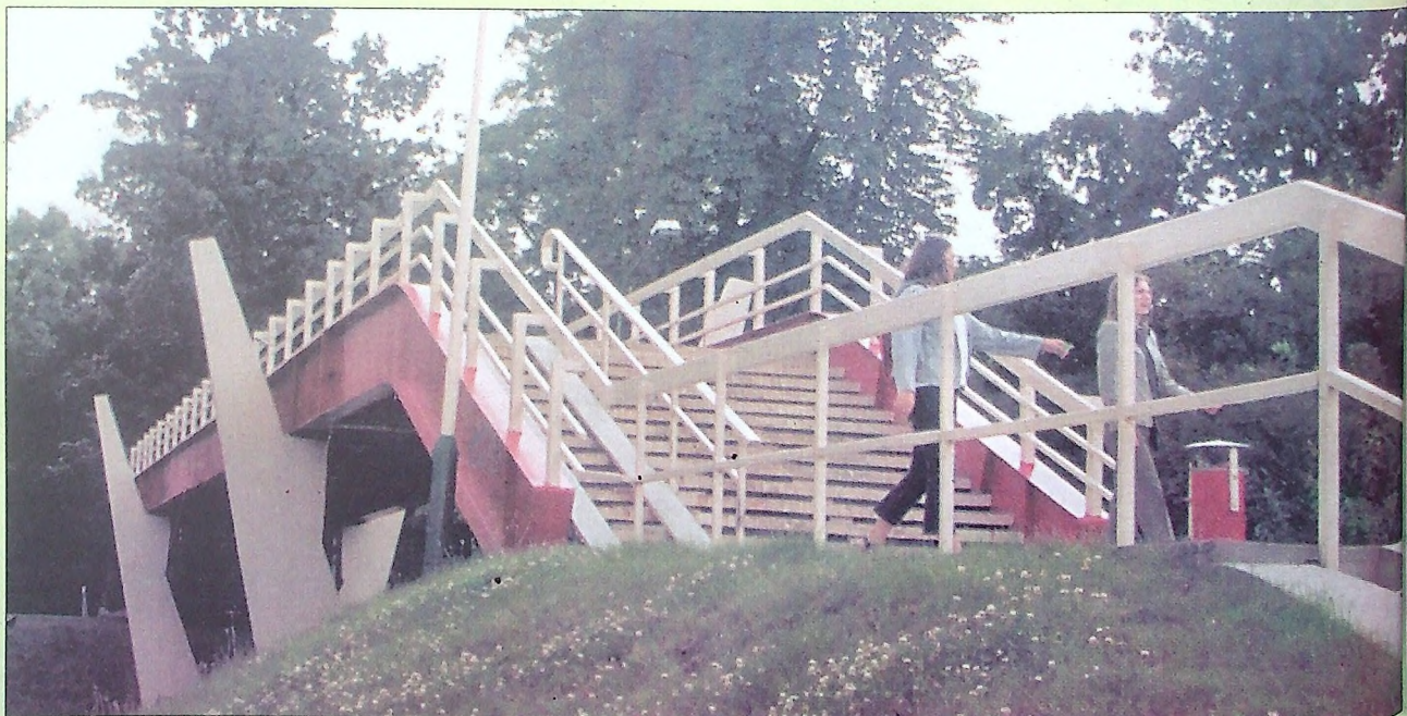
Wyremontowana kładka nad ul. Witelona
