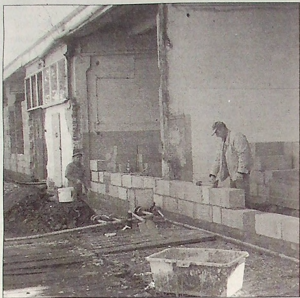
Rozpoczęła się modernizacja pomieszczeń produkcyjnych Lefany, wyremontowano większość dachów, wymieniono część okien, wykonywano są elewacje.
