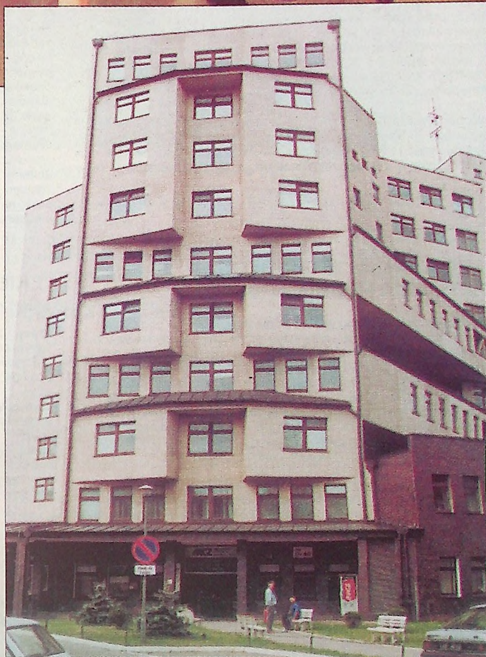
W tym budynku MCZ na IX piętrze ulokowano oddział onkologiczny.
