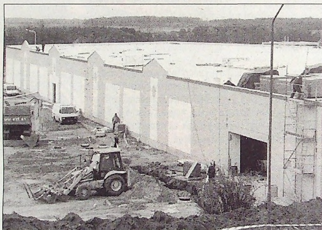
Budowa Kauflandu idzie pełną parą.
