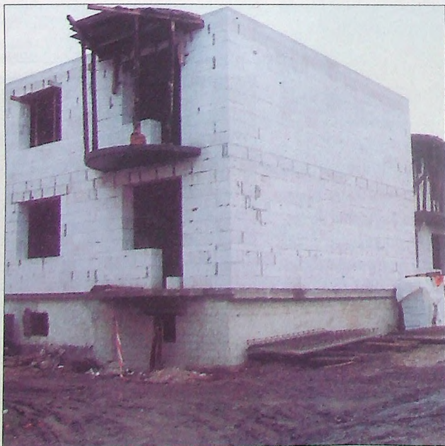
Przy ul. Starojaworskiej powstaje kolejny budynek TBS.
