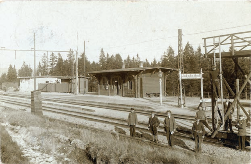
Źródło: Poczłtówka ze zbiorów prywatnych autora. Rycina 9. Prace elektryfikacyjne na stacji Jakuszye
