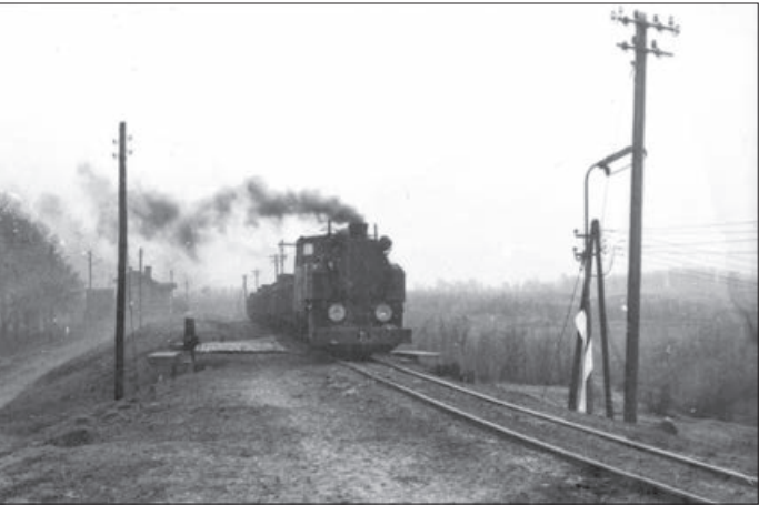
Źródło: Fot. A. Halor. Rycina 1. Podstawowym typem lokomotywy liniowej GKW przed wprowadzeniem lokomotyw spalinowych były najcięższe i najsilniejsze parowozy wąskotorowe eksploatowane przez PKP – tendraki serii Tw o masie 40 t. Na zdjęciu pociąg prowadzony parowozem Tw53 w Siemianowicach, 1969 r.
