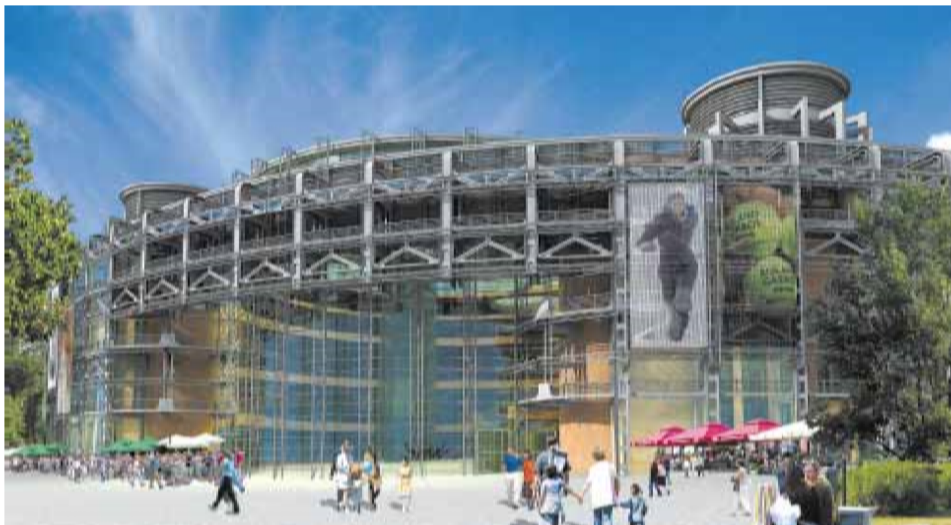
Powstające centrum handlowo-rozrywkowe będzie niewątpliwie wizytówką miasta i miejscem gdzie na zakupy przyjeżdżać będą klienci z całego regionu miedziowego. Na powierzchni 70 tysięcy metrów kwadratowych powstanie 6 sal kinowych, 150 sklepów, restauracje i kawiarnie. Oprócz tego powstanie wielopoziomowy parking oraz hotel.
