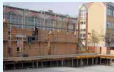
Trwa budowa basenu przy Gimnazjum nr 4.
