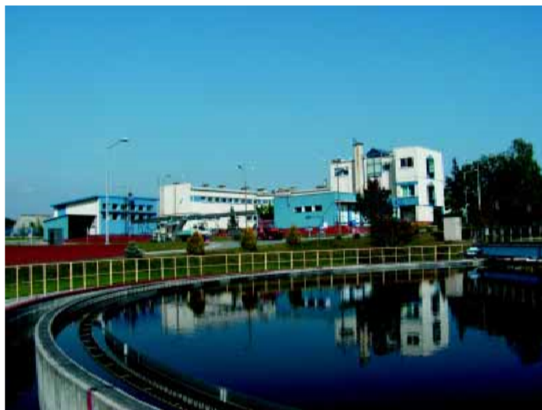
Budynek administracyjno-socjalny oczyszczalni ścieków
