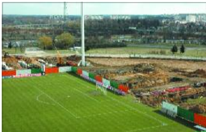
Kolejnym etapem budowy będzie montaż prefabrykatów
