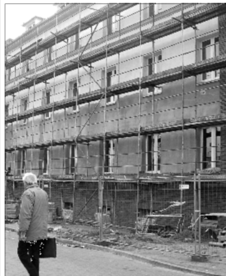
Od zewnętrznej strony starostwo zostało już ocieplone, teraz kładzione są tam tynki
