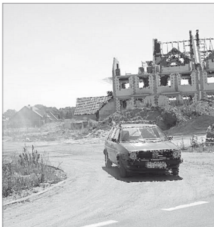
Na osiedlu Zalesie rozpoczął się trzeci etap rozbudowy
