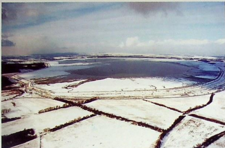
3. Składowisko odpadów poflotacyjnych „Żelazny Most”
