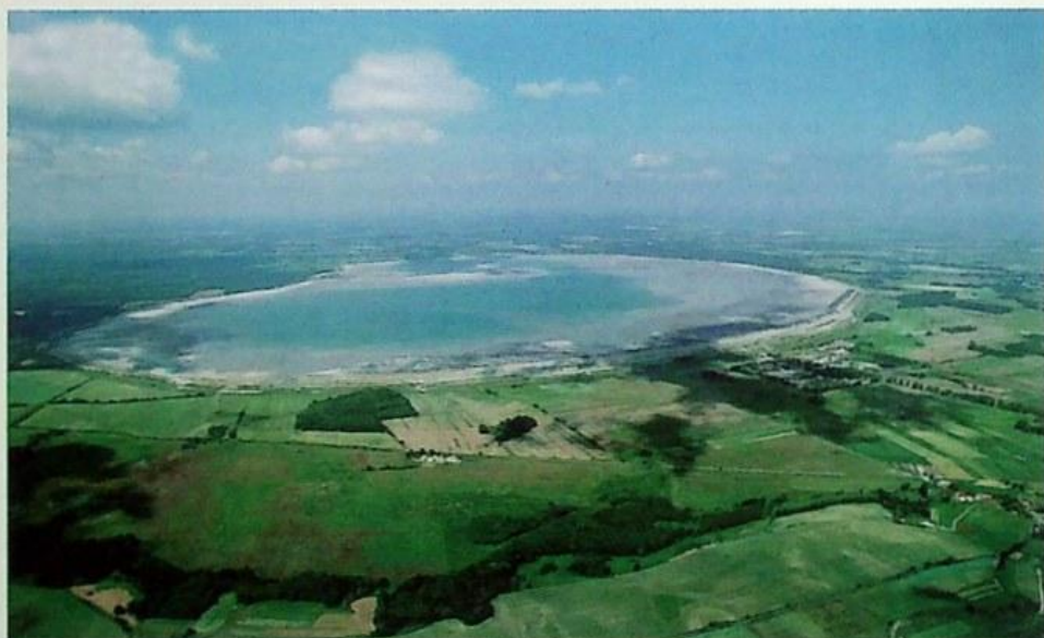
2. Składowisko odpadów poflotacyjnych „Żelazny Most”
