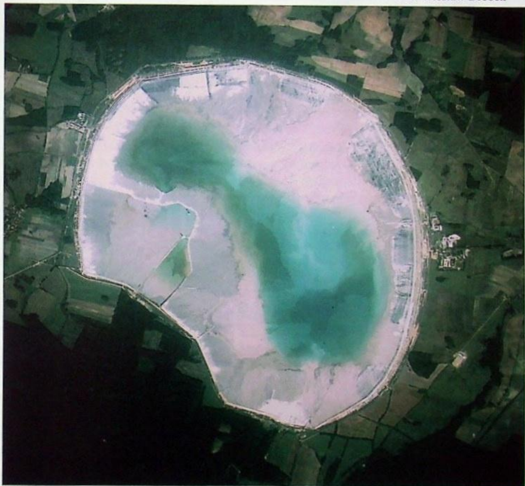
2. Składowisko odpadów poflotacyjnych „Żelazny Most”
