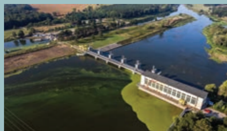
ELEKTROWNIA WODNA WAŁY ŚLĄSKIE
