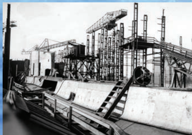
Budowa okrętu podwodnego ORP „Orzeł” w stoczni w Vlissingen, 1937 rok Źródło: NAC 3/1/0/7/2027.
