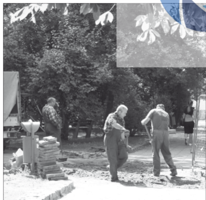
Po naszej interwencji i artykule, pracownicy WPEC zajęli się zabezpieczeniem wykopaliska
