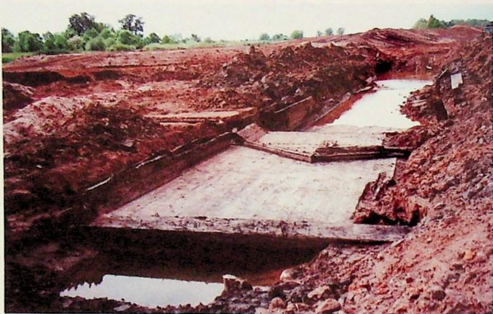
54. Stara, drewniana śluza odkopana podczas budowy stopnia wodnego Malczyce
