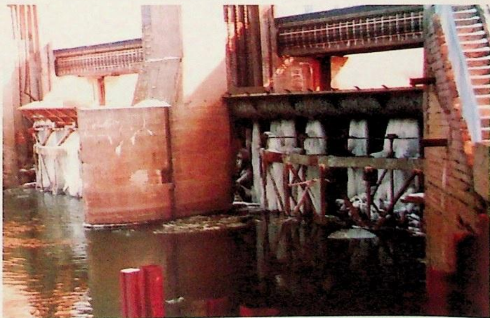
53. Jaz Brzeg Dolny – obłóczenie zasuw
