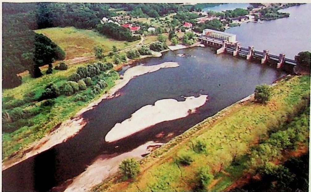
52. Jaz zasuwowy Brzeg Dolny (z kłapami do przepuszczania łodu), dolne stanowisko jazu podczas przepływów niżówkowych
