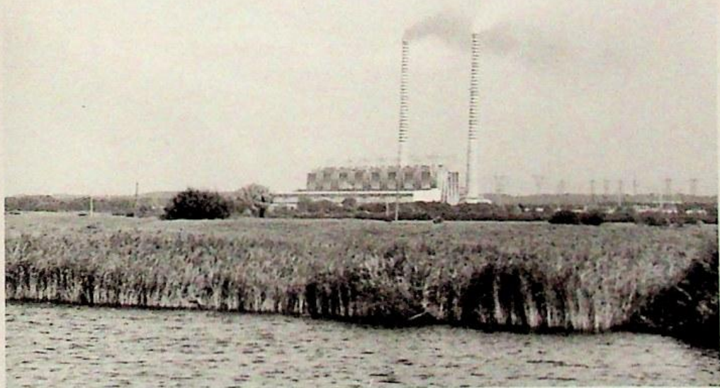
23. Elektrownia „Dolna Odra” w Nowym Czarnowie, 1981 r.
