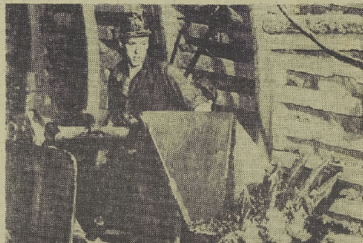
Rok 1963. Pierwsze 20 metrów chodnika posłanego w kopalni „Lubin” — szyb wschodni. Fot. S. Wolniewicz
