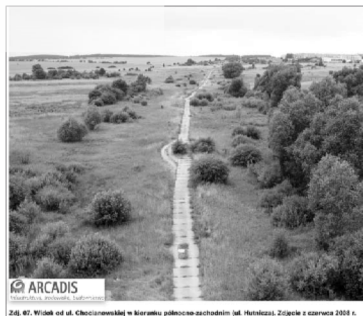
Zdj. 07. Widok od ul. Chocianowskiej w kierunku północno-zachodnim (ul. Hutnicza). Zdjęcie z czerwca 2008 r.
