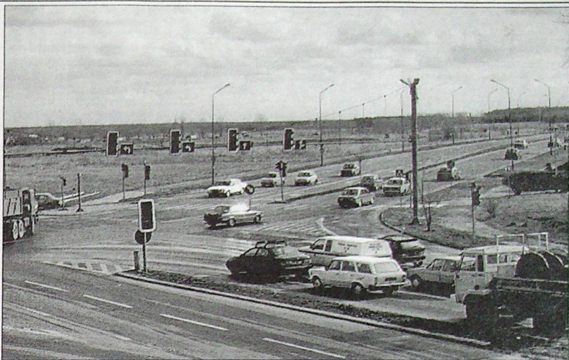
Widok na ulicę Piłsudskiego. Na pierwszym planie sygnalizacja świetlna nad ulicą KEN.
