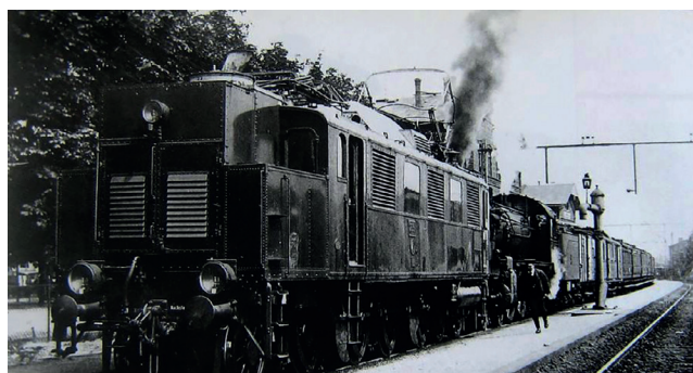
Elektrowóz EP235 na czele składu - Szczawienko, 1917 r.
