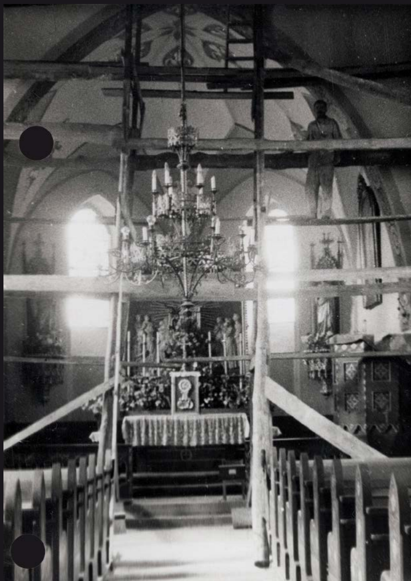
Remont kościoła pod wezwaniem Najświętszego Serca Pana Jezusa, rok 1950
