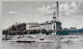
■ Stacja Elektryczna. Miejsce forsowania Wilni pod ogniem niemieckim przez kompanię AK Dzielnicy A przy wsparciu sowieckiej artylerii Fot. Zbiory Biblioteki Narodowej
