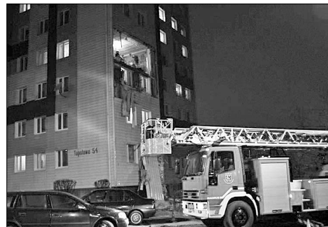
Eksplozja nie naruszyła ścian nośnych budynku
