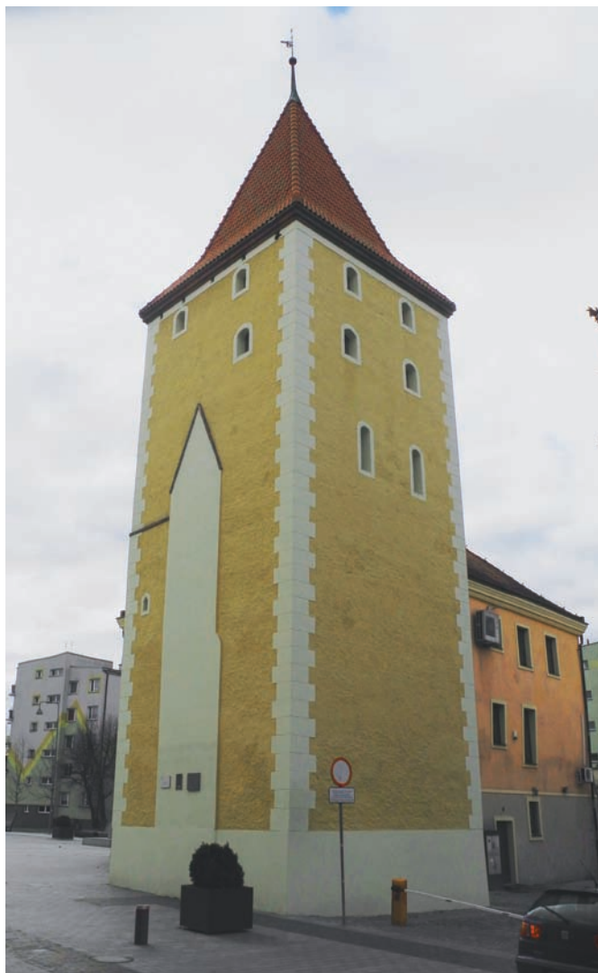
Baszta Głogowska od strony północnej. Na jednej ze ścian widoczny ślad przylegania pierwotnego muru obronnego z bramą wjazdową. Fot. Piotr Bieruta, 2023 r.
