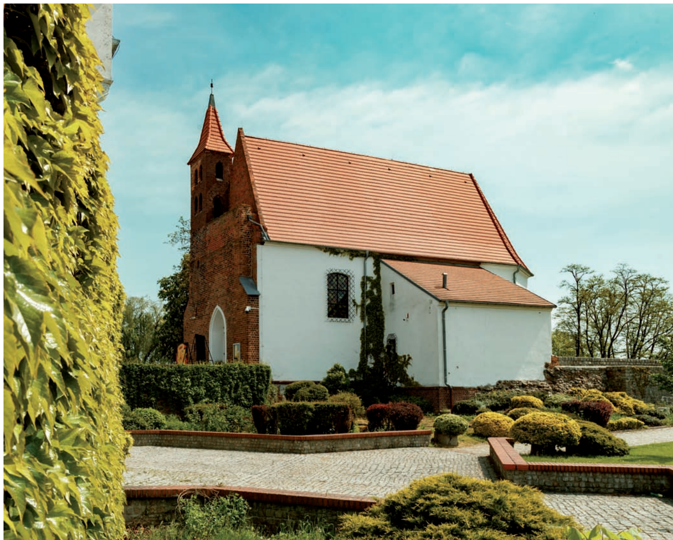
Kaplica zamkowa. Widok od strony południowej. Fot. Tomasz Folta, 2023 r.
