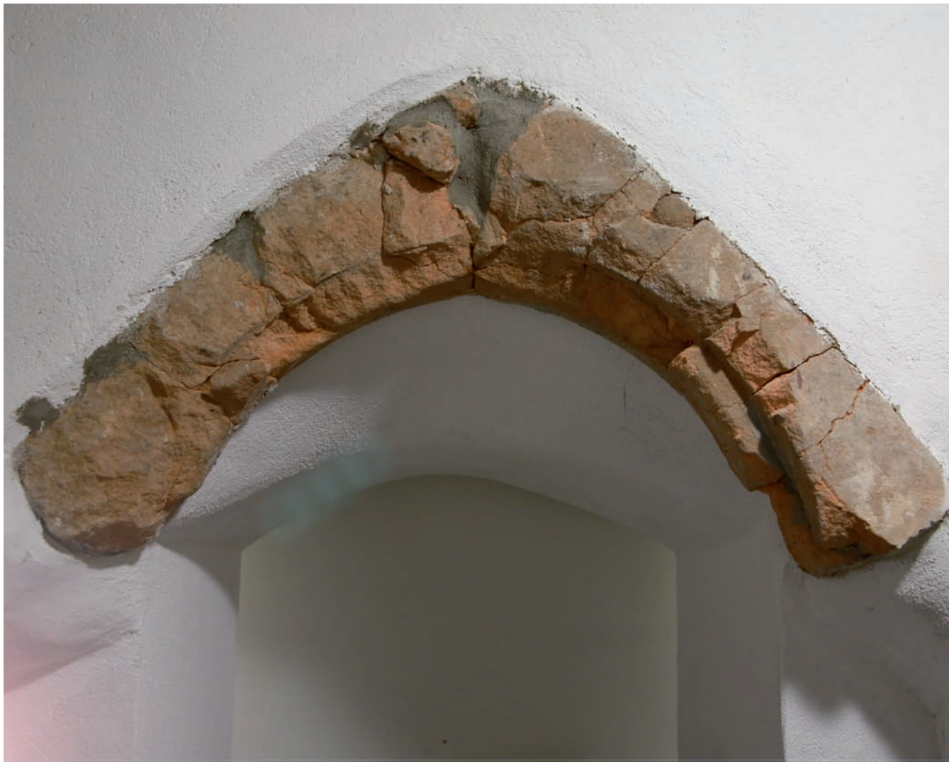
Nadproże znajdujące się w piwnicy to jeden z najstarszych elementów architektonicznej struktury ratusza. Fot. Piotr Bieruta, 2024 r.
