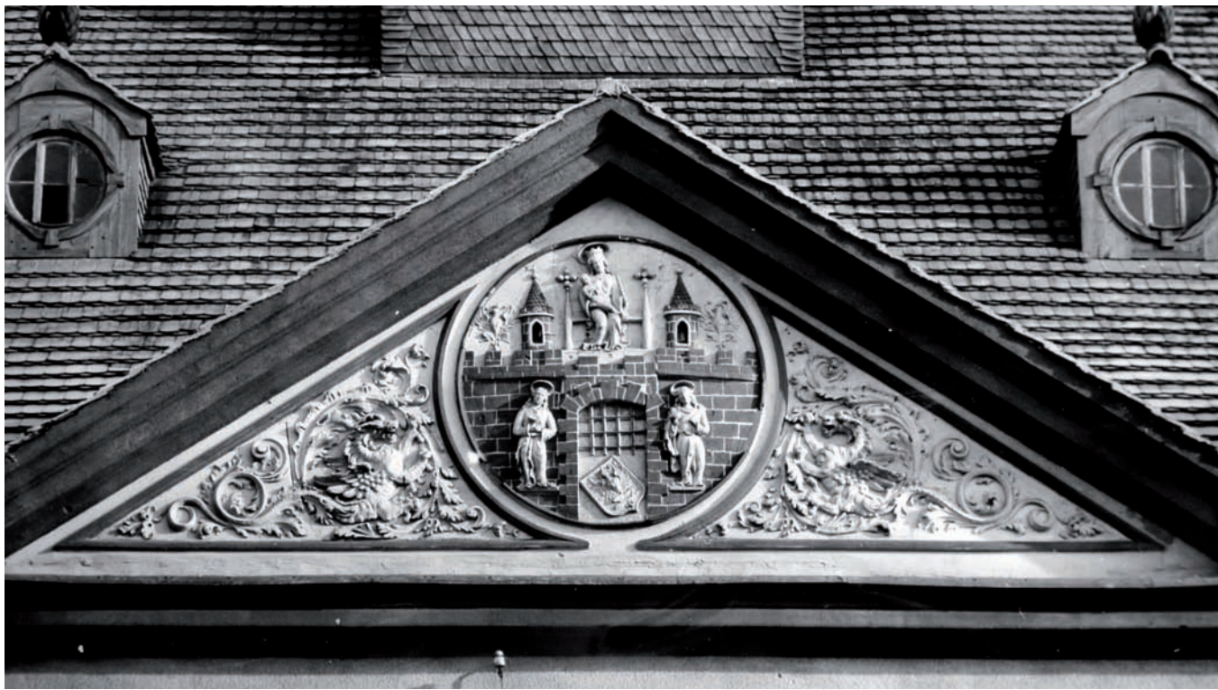
Płaskorzeźbiony herb Lubina w przycółku nad elewacją południowo-zachodnią. Fot. Józef Milka, 1968 r.
