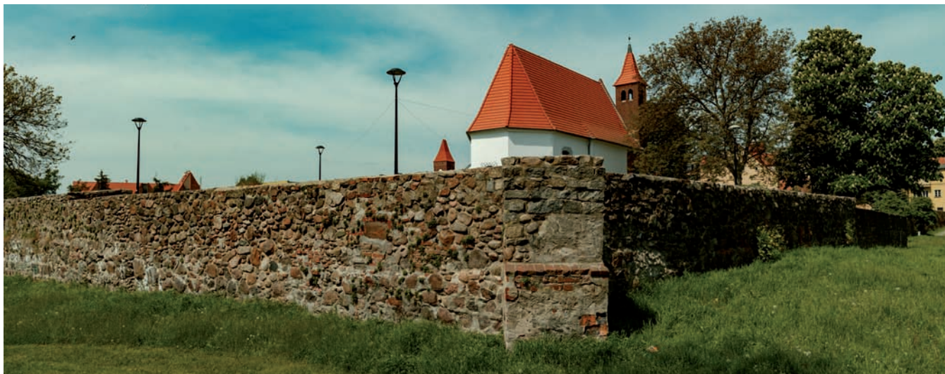
Prace rekonstrukcyjne murów obronnych terenu dawnego zamku piastowskiego. Fot. Leszek Dobrzyniecki, 1988 r.
