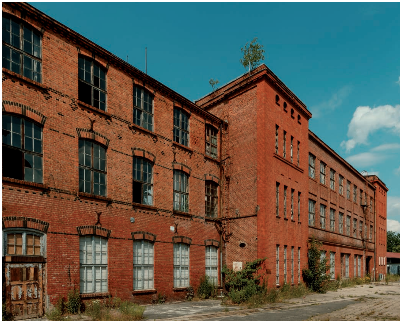
Budynek produkcyjny fabryki (skrzydło zachodnie oraz gmach główny). Fot. Tomasz Foltą, 2023 r.
