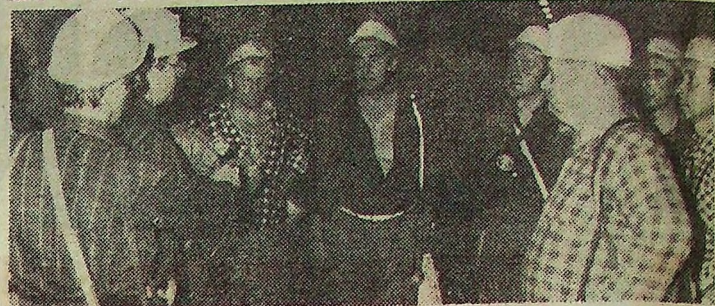
W rejonie szybów zachodnich kopalni „Lubin” otwarto nową komorę remontowo-przeładową. Inwestycję oddano do użytku przed terminem. Warto przy tym dodać, że kopalnia własnymi siłami prowadziła roboty górnicze, a załoga PBKR Częstochowa podjęła się prac montażowych.
