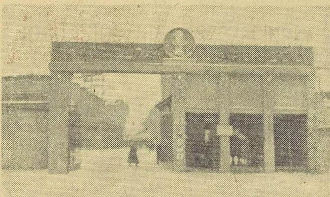
Stocznia Szczecińska — brama wejściowa, przed którą kilka chwil czekania na wypisanie przepustek wydawało nam się rokiem. Tym bardziej, że z daleka widać było sylwetkę statku.
