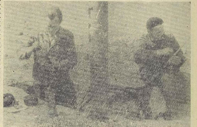
Do wkopanych słupów monterzy podłączają specjalny kabel ziemny. Praca ta wymaga precyzji i cierpliwości przy izolowaniu i zabezpie- czeniu liczących końcówek.
