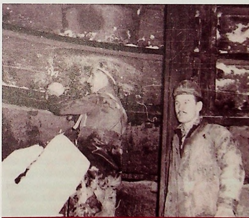
Szyb „Bolesław”. Obudowa tubingowa stała. Cieśla Władysław Rosicki rozplaszcza uszczelki ołowiane między tubingami. Obok Kazimierz Wilanowski.
