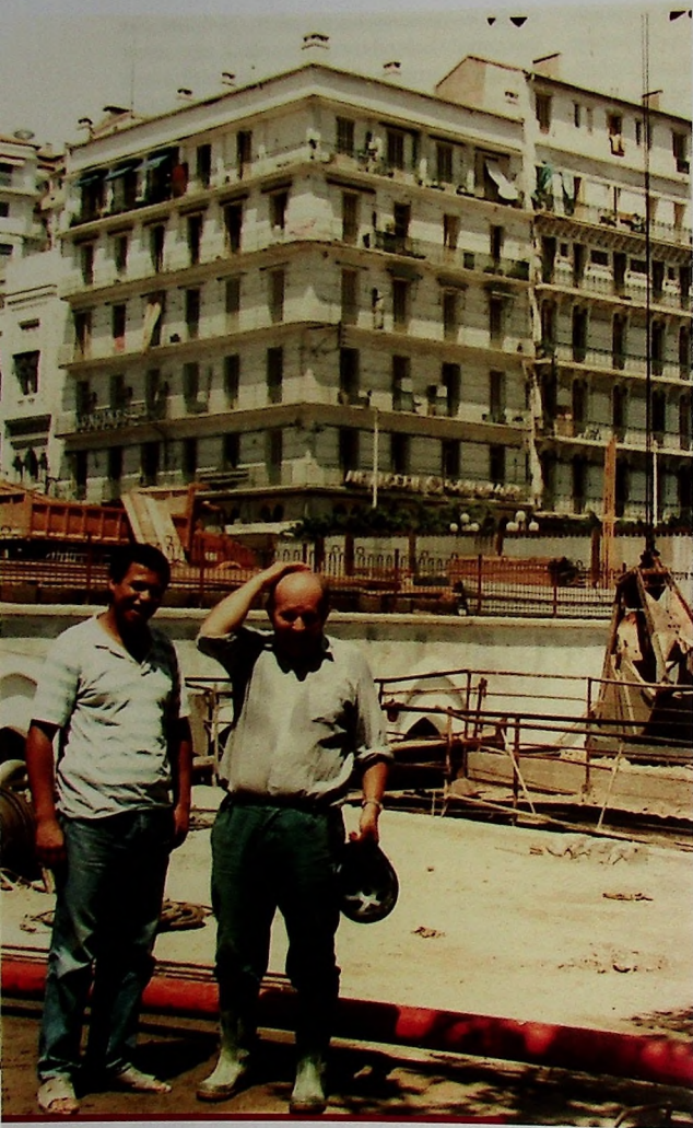
Jerzy Turlej z algierskim inżynierem na budowie metra w ścisłym centrum stolicy. Z pierwszego piętra budynku, który widać w tle, generał de Gaulle ogłaszał niepodległość Algierii.
