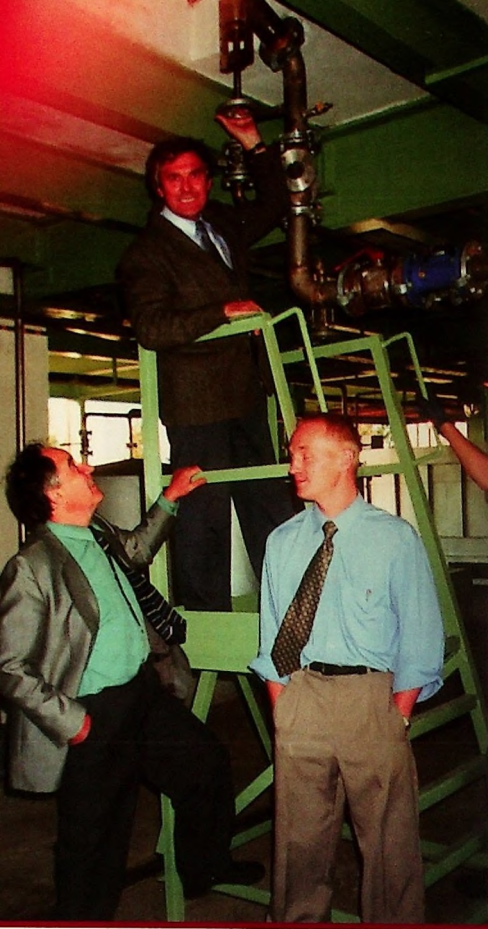
Rok 2000. Odbiór nowej instalacji do produkcji ksantogেনianów. Od lewej dyr. Spiro Gagaczowski, kier. działu mechanicznego, Zbigniew Tutaj oraz Łukasz Latos, kier. wydziału produkcji ksantogেনianów.
