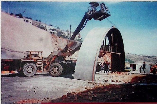
Montaż szalunku w tunelu budowanym w Jerozolimie, 1994 rok.
