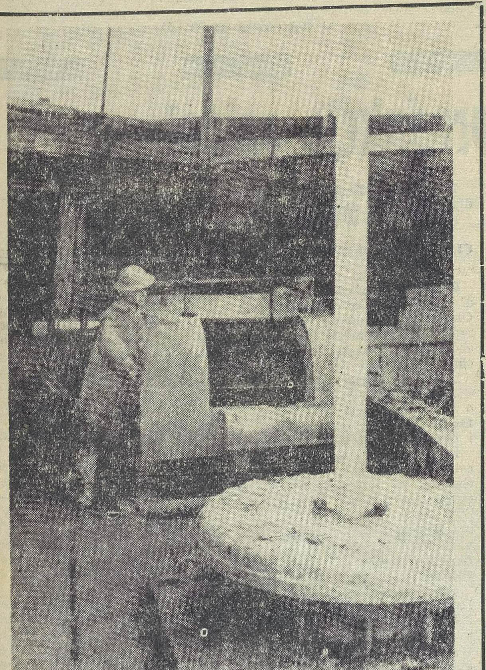
Kopalnia „Lubin”. Wiercenie otworów mroźniowych przy szybie głównym. fot. A. Waclawek
