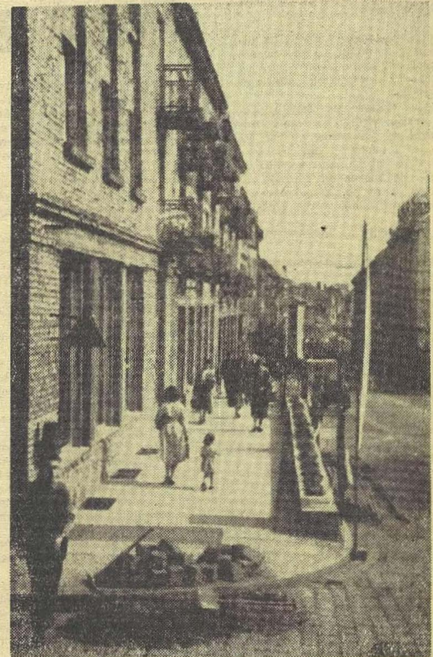
Nowo odbudowane bloki przy pl. Wolności w Złotoryi fot. A. Wacławek
