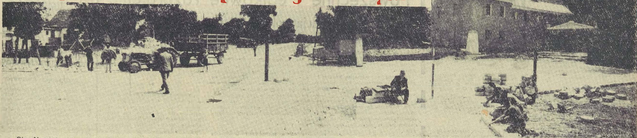
Oto główny front robót w Wądrożu Wielkim. Po prawej: na pierwszym planie, robotnicy POM budują kryty przystanek autobusowy, w głębi nowo odremontowany gmach Banku Spółdzielczego (nowy dach i elewacja). W środku: nowo zbudowana droga długości około 0,25 km, która ciągnie się od placu Rynekowego aż do Szkoły. Z lewej: budowa stupa ogłoszeniowego przez robotników miejscowego PGR.
